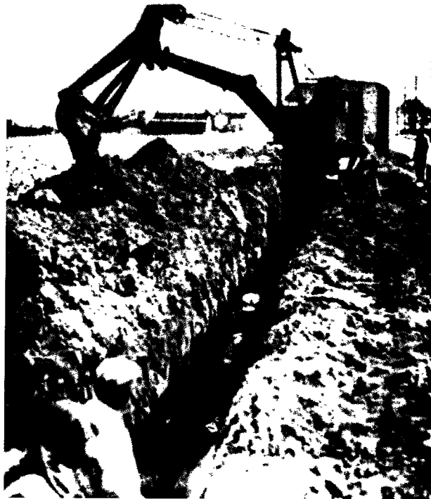
Gambar 8-43. Back Hoe digunakan untuk menggali parit
