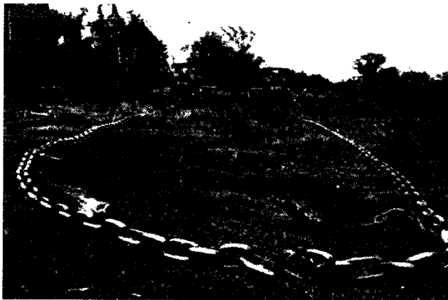
Gambar 4-14. Rantai ditarik traktor digunakan untuk membersihkan lahan.
